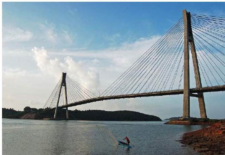
Jembatan Raja Haji Fisabilillah
