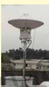
Ground Satellite Receiver berguna untuk pengamatan cuaca jarak jauh dengan cakupan area yang luas. Jenis Satelit yang mengirimkan sinyal ke Ground Satellite Receiver ada 2 macam yaitu Geostasioner (Satelit MTSAT) dan Polar Orbital (Satelit NOAA).
